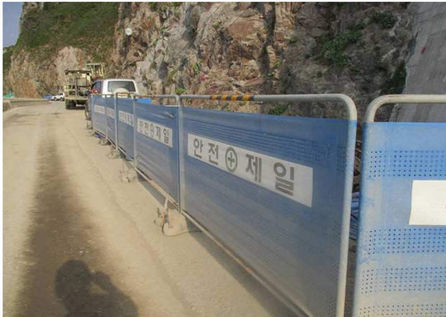
도로 안전 펜스 현황
