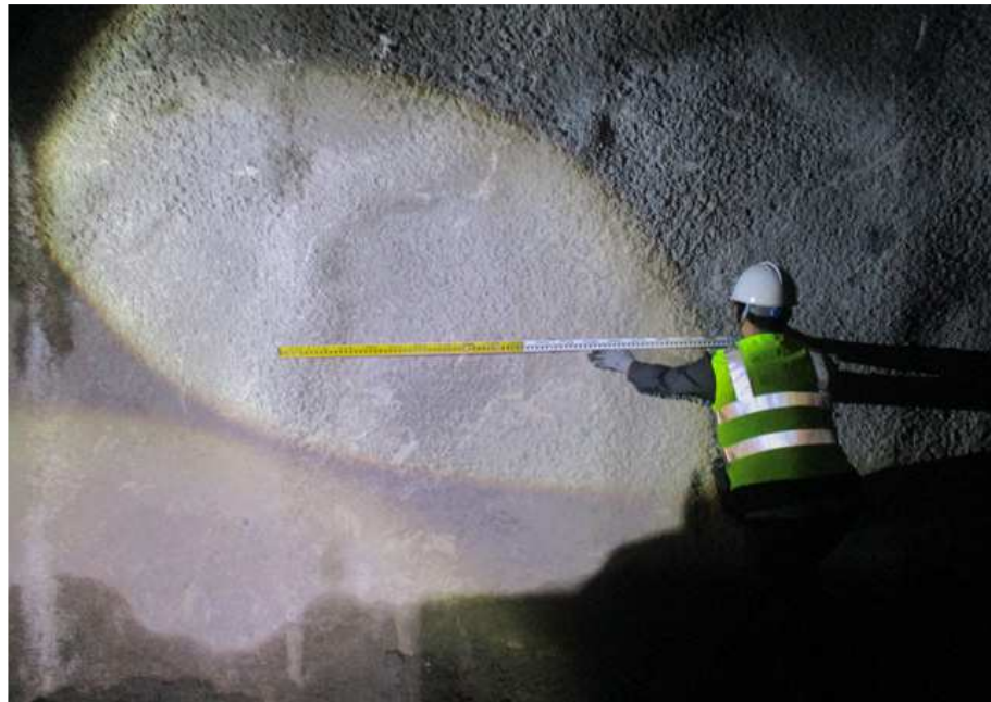
STA 2+660 강지보재 현황
