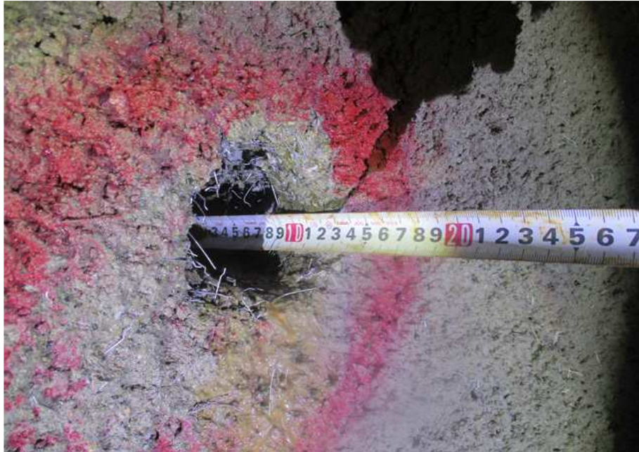
STA 2+665 솟크리트 현황
