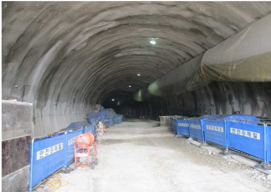
북면터널 시점부 내부 전경
