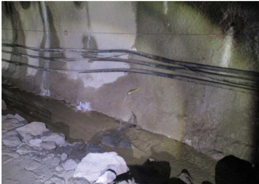
STA 2+610 수발공 설치 현황
