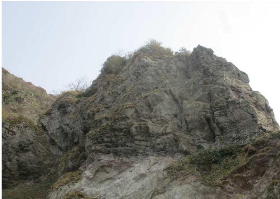
시점측 상부 이완암 현황
