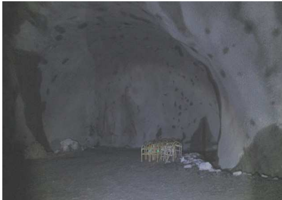
STA 0+960(방향전환소) 현황
