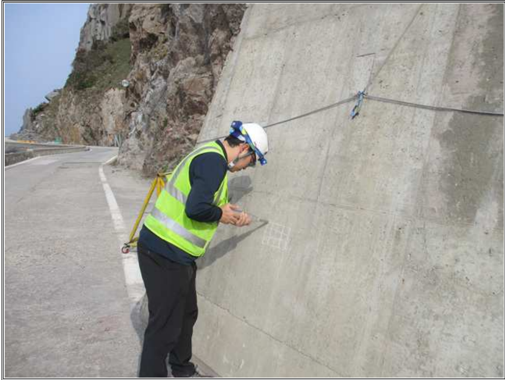
콘크리트 반발경도 측정 현황
