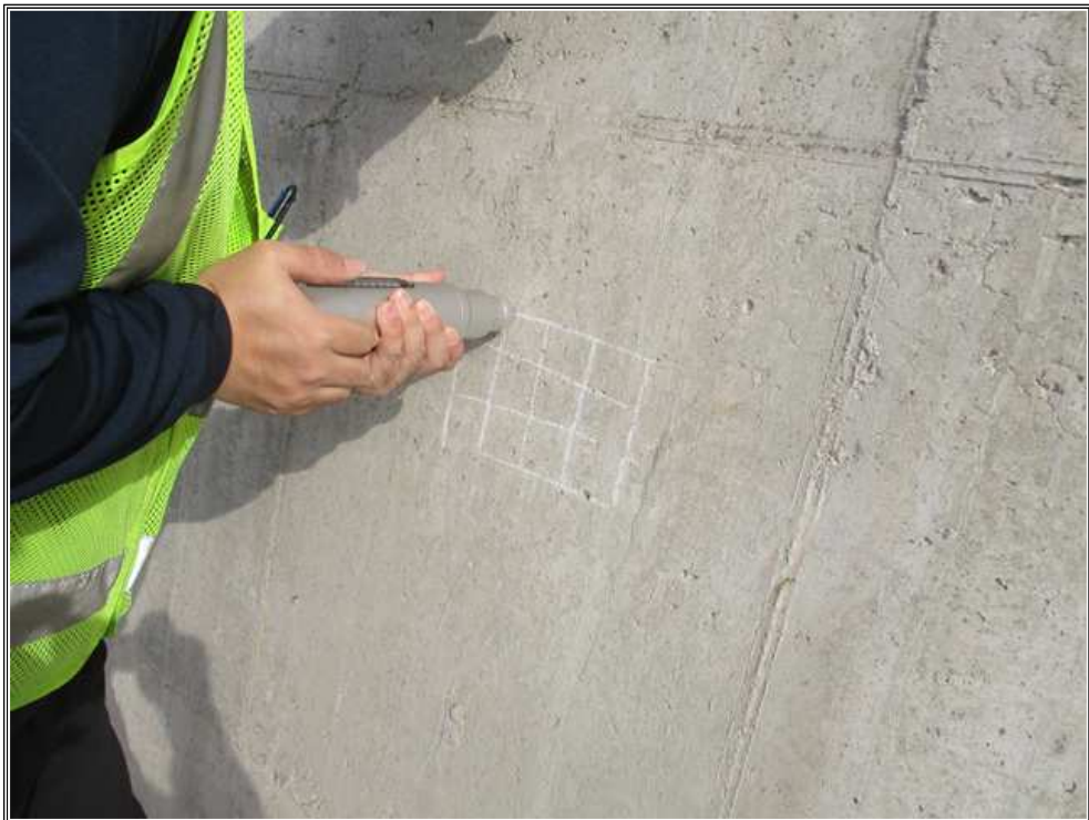
콘크리트 반발경도 측정 현황
