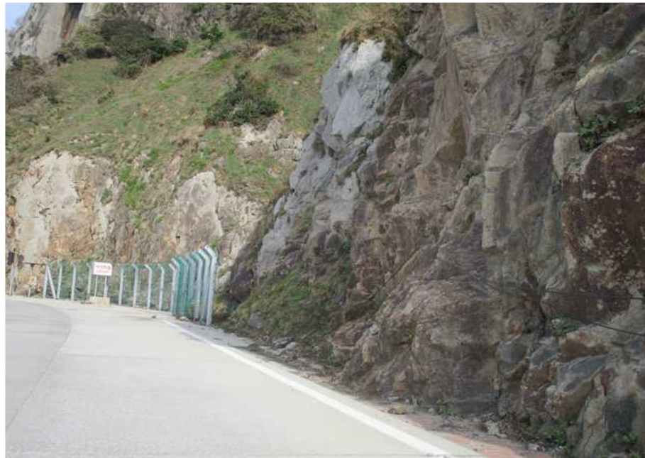
인접구간 낙석방지울타리 현황
