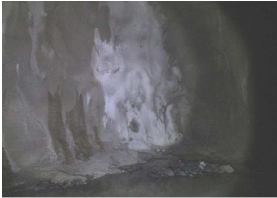
STA 2+850 터널 굴착 현황
