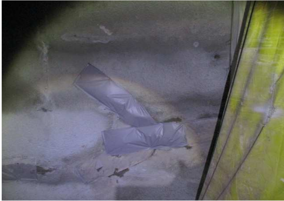
STA 2+650 방수막 설치 현황
