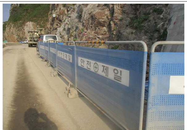
도로 안전 펜스 현황
