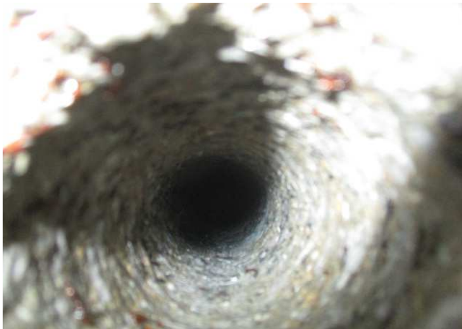
STA 2+665 솟크리트 현황
