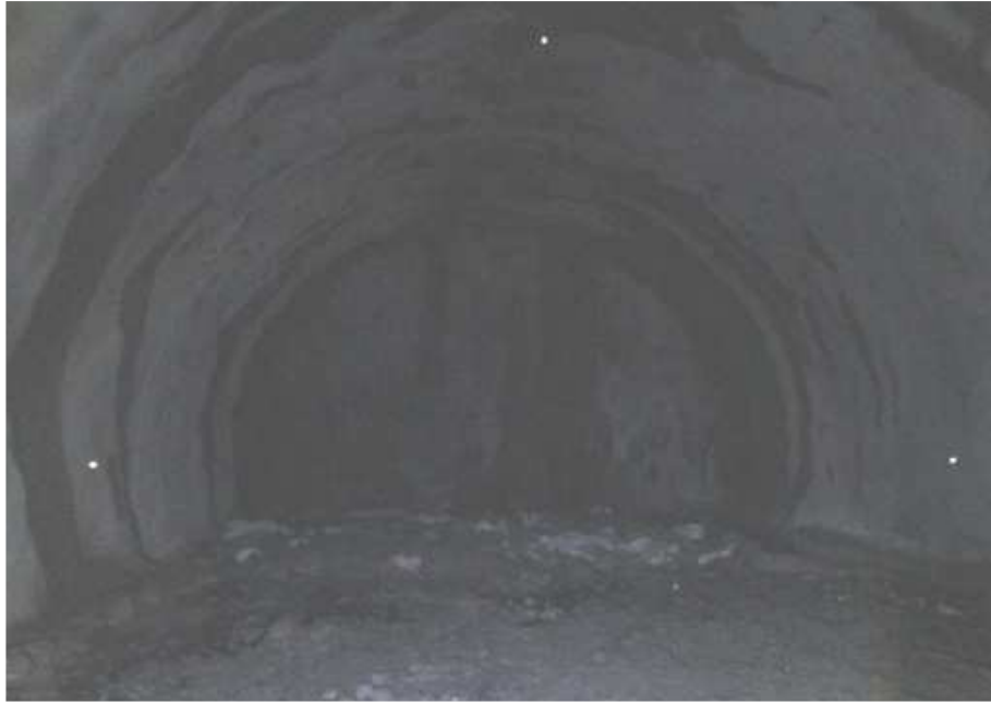
STA 2+850 터널 굴착 현황
