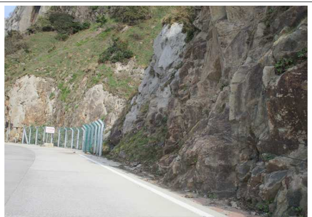
인접구간 낙석방지울타리 현황
