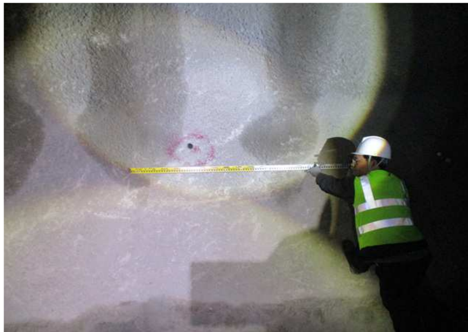
STA 2+665 강지보재 현황
