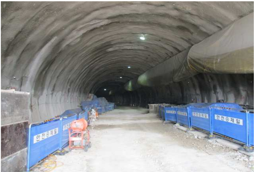
북면터널 시점부 내부 전경
